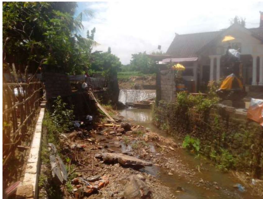
Hulu saluran yang menuju Permukiman Jalak Putih (Lebar \pm 5 Meter)
