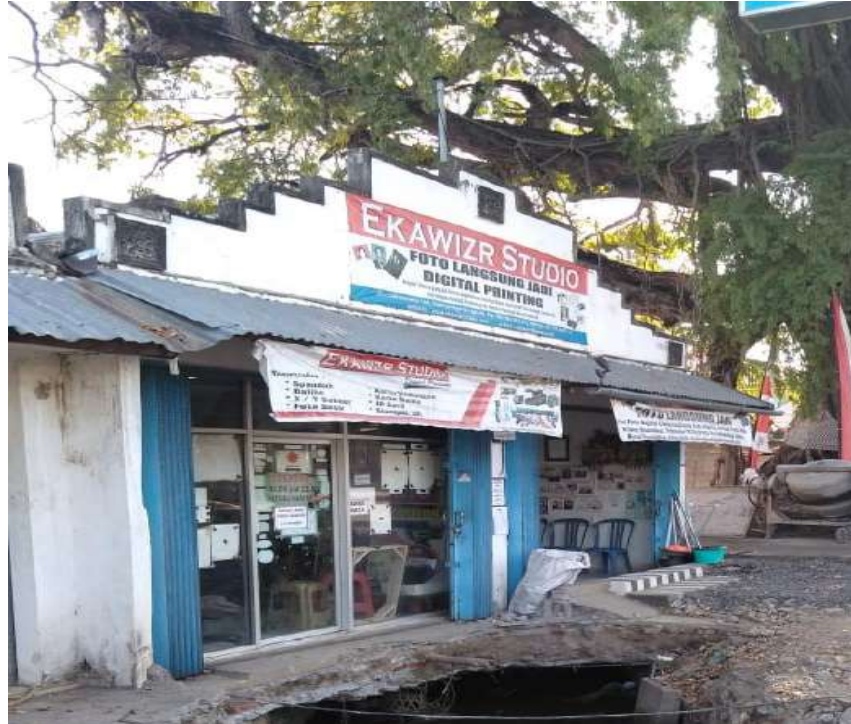
Contoh Pendirian Bangunan Diatas Saluran (sudah dibongkar oleh Aparat Desa atas seijin pemilik bangunan)
